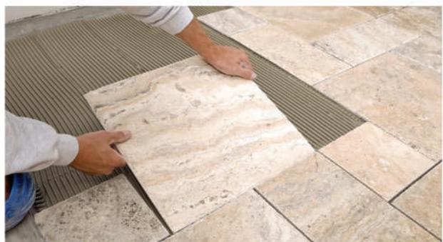
چسب سنگ ، جهت چسباندن سنگ های با جذب آب صفر (مطلق) و کاشی کاری در بسترها یی که در معرض رطوبت هستند و همچنین از جذب آب پایینی برخوردارند می توان از این محصول ویژه استفاده نمود. این محصول از مقاومت چسبندگی کششی بالایی برخوردار بوده و مناسب جهت چسباندن سنگ های با وزن بالا بر روی دیوار و کف می باشد.
