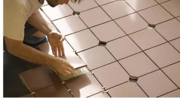
پودر بند کشی یا مرز بندی، محصولی آماده است که تنها نیاز به اضافه نمودن آب دارد تا برای استفاده آماده شود. از این فراورده برای بستن و نفوذ ناپذیری درزهای بین کاشی، آجر، سرامیک و سنگ نصب شده بر روی سطوح استفاده می‌کنند و درز را ضد آب می‌کنند.
