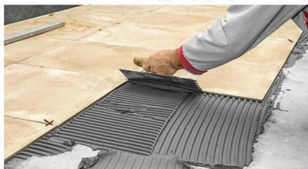
چسب کاشی پرسلان یک نوع ملات خشک است که بر پایه سیمان ساخته شده و به طور خاص برای نصب کاشی و سرامیک بر روی دیوارها و کفها، همچنین در محیط‌هایی مانند استخر و سونا طراحی شده است. این چسب به دلیل ویژگی‌های منحصر به فرد خود، از جمله مقاومت بالا و ضد آب بودن، به یک گزینه ایده‌آل برای پروژه‌های ساختمانی تبدیل شده است.
