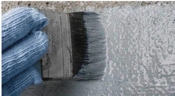
نفوذگر کریستال شونده، مخصوص آب بندی فشار منفی است و ضد آب از طریق تبلور می‌باشد. مواد شیمیایی فعال بکار رفته در نفوذگر کریستال شونده به آهک آزاد شده و رطوبت موجود در ترک‌های ظریف بتن را پوشش داده و مجموعه‌ای از بلورهای غیر محلول را تشکیل می‌دهد. این بلورها از ورود بیشتر آب به ترک‌ها و انقباضات جلوگیری می‌کند و مسیر حرکت آب پشت دیوار عوض می‌شود.
