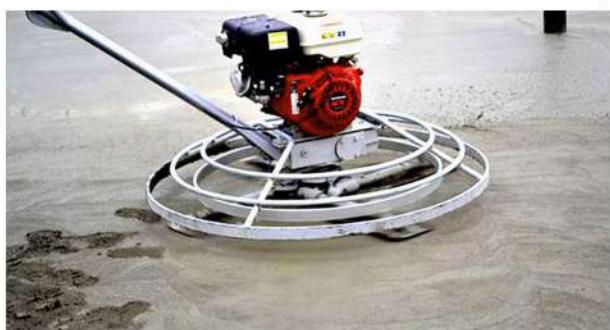
نوعی ترکیب پودری سیمانی که به دو روش ملاتی و خشکه پاشی می‌تواند با قرار گرفتن بر روی بتن تازه مورد استفاده قرار گیرد و موجب دوام و پایداری بیشتر سطوح کف سازی می‌شود. سپس به منظور یکپارچه سازی سطح عملیات مربوط به ماله کشی با دستگاه‌های نظیر ماله پروانه انجام می‌گیرد و مقاومت سایشی را افزایش می‌دهد.
