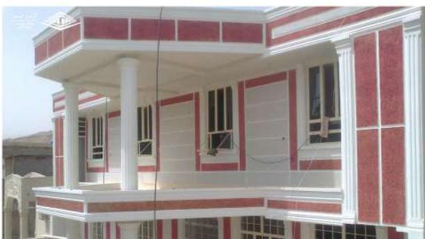
این محصول نوعی پوشش نیمه ترئین شده‌است. با استفاده از یک ماله مخصوص می‌توان ترئینات کلاسیک بر روی آن ایجاد کرد. ضخامت آن تقریباً 2 تا 3 میلی‌متر بوده و در رنگ‌های مختلف عرضه می‌شود و قابلیت اجرا به صورت پاشش روی نما را دارد.
