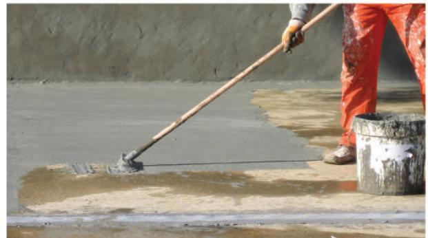
محصول پلیمری مخصوص آب بندی فشار ثابت، بسیار انعطاف پذیر و بر پایه سیمان است که به صورت مخلوط یک جز پودری و یک جز محلول پلیمری استفاده می شود و عایقی ضد آب با مقاومت در برابر رطوبت 100% می باشد که قابلیت محافظت از انواع بتن و ملات در تنش های احتمالی را دارد و تحمل تنش های سازه ای را دارد. پلیمر سیمانی را می توان در سطوح سیمانی مختلف، سازه های دریایی، عایق بندی زیر زمینها، عایق بندی مناطق مرطوب، سقفها، استخرها، مخازن آب و ... بکار برد.
