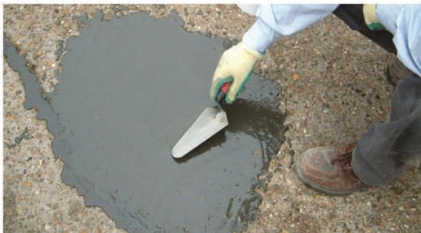
پلاستر ترمیم کننده پوشش نازک کاری نوعی ملات سیمانی مناسب و پیش ساخته است که برای مصارف داخلی و بیرونی بکار می‌رود. از این ملات همچنین می‌توان در گچ کاری و یا تعمیرات موضعی بر روی قسمت‌هایی که دارای سیمان پرتلند هستند مانند بتن‌ها یا سطوحی که بر روی آن‌ها دوغاب پاشیده شده استفاده کرد. از ملات ترمیمی زیر برای مواضعی که خلل و فرج بالایی وجود دارد می‌توان استفاده نمود.
