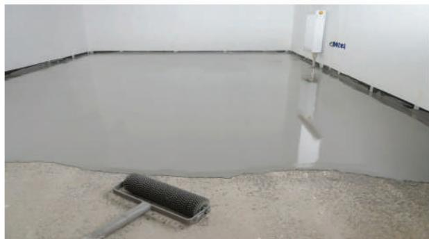
محصول به دلیل ویژگی هایی نظیر مقاومت بالای فیزیکی و شیمیایی، زیبایی و براقیت، قابل عرضه در طیف وسیعی از رنگ ها و امکان اجرا در ضخامت بالا، کاربرد بسیار گسترده ای در پوشش های کف دارد. اجرای یکپارچه و نداشتن درز باعث شده تا این محصول گزینه بسیار مناسبی برای کفپوش محیط های پارکینگ، فضای کارخانه ها، محوطه های بیمارستانی و بهداشتی باشد.
