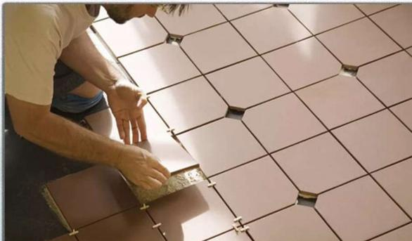
پودر بند کشی یا مرز بندی، محصولی آماده است که تنها نیاز به اضافه نمودن آب دارد تا برای استفاده آماده شود. از این فرآورده برای بستن و نفوذ ناپذیری درزهای بین کاشی، آجر، سرامیک و سنگ نصب شده بر روی سطوح استفاده می‌کنند.
