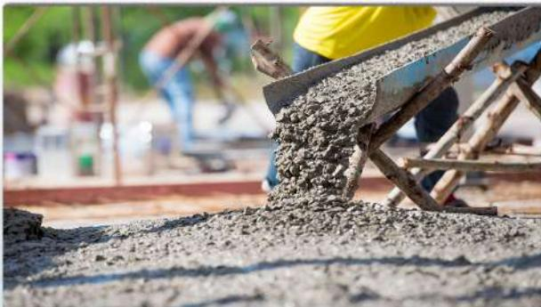
از میکروسیلیس و ژل میکروسیلیس برای تولید بتن آب بند و بتن با مقاومت بالا استفاده می شود، همچنین از ژل میکروسیلیس و میکروسیلیکا جهت تولید بتن نفوذناپذیر برای استفاده در ملات و گروت ها استفاده می گردد.
