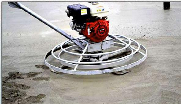
نوعی ترکیب پودری سیمانی که به دو روش ملاتی و خشکه پاشی می‌تواند با قرار گرفتن بر روی بتن تازه مورد استفاده قرار گیرد و موجب دوام و پایداری بیشتر سطح کف سازی می‌شود. سپس به منظور یکپارچه سازی سطح عملیات مربوط به ماله کشی با دستگاه‌های نظیر ماله پروانه انجام می‌گیرد.
