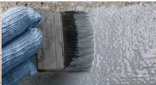
این محصول نفوذگر کریستال شونده، مخصوص آب بندی فشار منفی است و ضد آب از طریق تبلور می باشد. مواد شیمیایی فعال بکار رفته در نفوذگر کریستال شونده به آهک آزاد شده و رطوبت موجود در ترکهای طریف بتن را پوشش داده و مجموعه ای از بلورهای غیر محلول را تشکیل می دهد. این بلورها از ورود بیشتر آب به ترک ها و انقباضات جلوگیری می کند و مسیر حرکت آب پشت دیوار عوض می شود.
