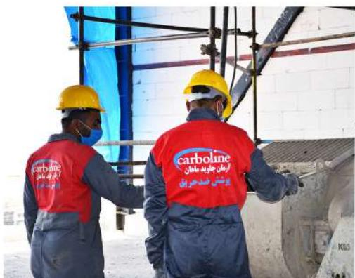
اجرای آسان توسط انواع دستگاه های ملات پاش و اسپری و ماله وزن سبک معادل یک پنجم وزن بتن استفاده شده برای مقاومت یکسان در برابر آتش قابلیت استفاده در تمامی شرایط (فضاهای داخلی، نیمه در معرض و معرض) قابلیت استفاده در پارکینگ هایی که در آن ها آب ریزیش در زمان کاربری وجود دارد ماندگاری و عمر مفید محصول بر اساس آزمون های ماندگاری ۲۵ سال می باشد.
