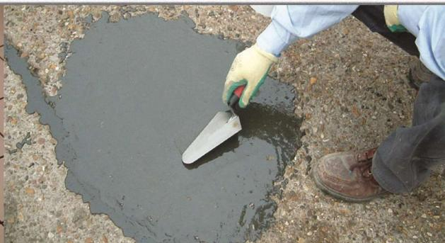
پلاستر ترمیم کننده پوشش نازک کاری نوعی ملات سیمانی مناسب و پیش ساخته است که برای مصارف داخلی و بیرونی بکار می‌رود. از این ملات همچنین می‌توان در گچ کاری و یا تعمیرات موضعی بر روی قسمتهایی که دارای سیمان پرتلند هستند مانند بتن ها یا سطوحی که بر روی آن ها دوغاب پاشیده شده استفاده کرد.
