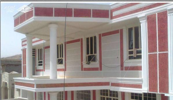
این محصول نوعی پوشش نیمه تزئین شده است. با استفاده از یک ماله مخصوص می توان ترینیتات کلاسیک بر روی آن ایجاد کرد. ضخامت آن تقریباً ۲ تا ۳ میلی متر بوده و در رنگ های گوناگون عرضه می شود.
