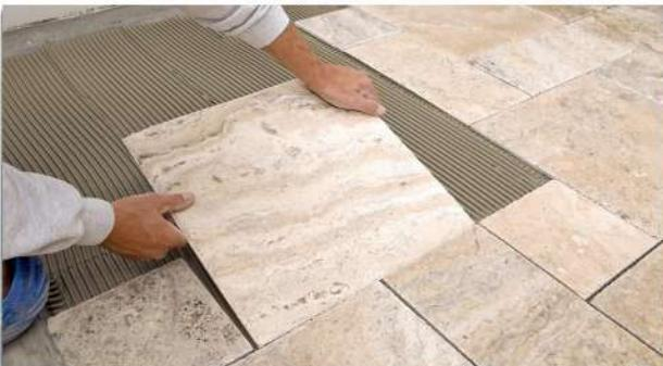
چسب سنگ پرسلانی، جهت چسباندن سنگ های با جذب آب صفر (مطلق) مورد استفاده قرار می گیرد، کاشی کاری در بستر هایی که در معرض رطوبت هستند و همچنین از جذب آب پایینی برخوردارند می توان از این محصول ویژه استفاده نمود.
